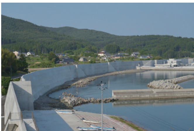
門之浜湾の防潮堤
