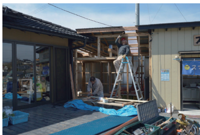
倉庫への屋根設置
