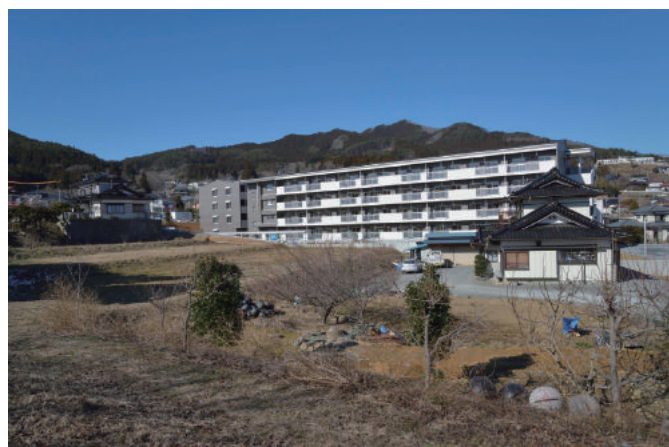
災害公営住宅（平南アパート）
