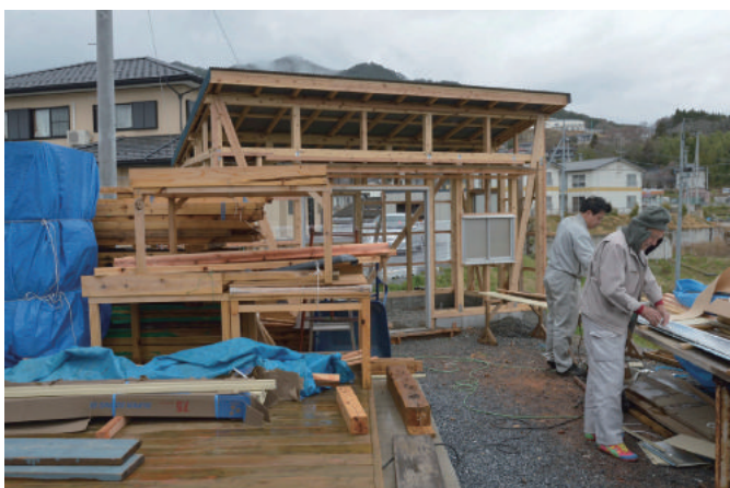
食堂の調理場の建設 (2015年4月11日)
