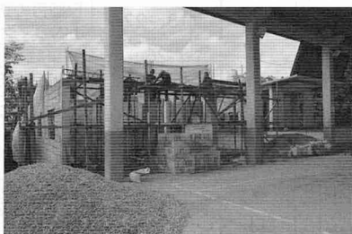
写真11 建設中の拠点
