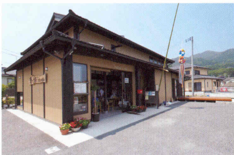
写真① 古民家を移築・再生した建物
